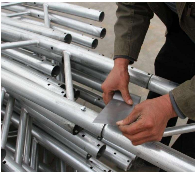
Rys.10 Zabezpieczenie połączeń taśmą naprawczą.
